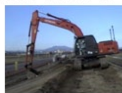
現場施工状況(盛・切土)
