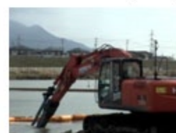
現場施工状況(浚渫)
