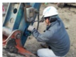
重機取り付け作業
